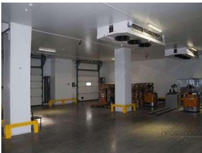
Рисунок 13: Обшивка колонн
